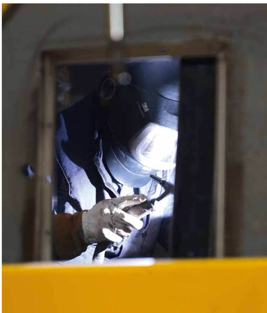
Un operario trabaja en la soldadura de un blindado para el Ejército de Tierra en una fábrica de Asturias
